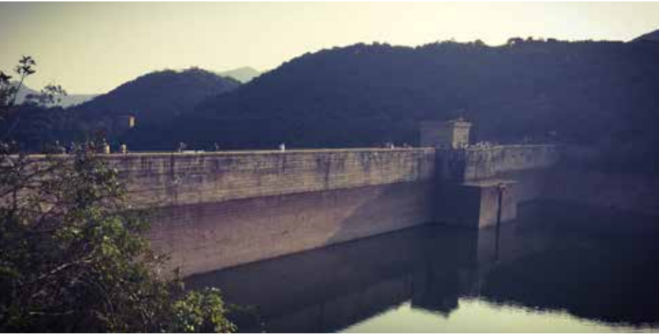
Den vackra reservoaren i Tai Tam är välbesökt på helgerna och en del av Hong Kong Trail.
